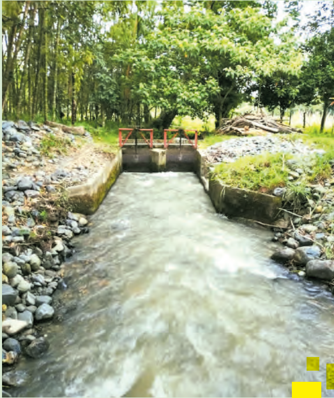
Obra derivación N° 03 Río Bolo
